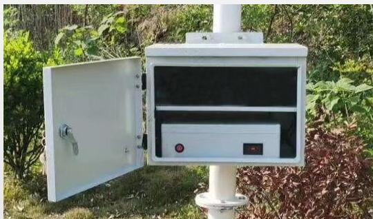
4. 安装太阳能配电箱，放入太阳能锂电池
