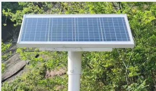
3. 旋转太阳能电池板，将聚热面尽量对着日照时间长的方向。
