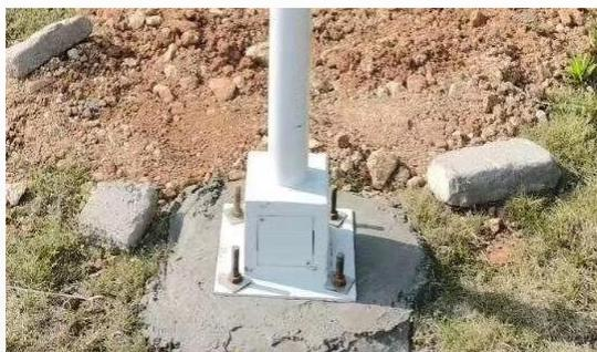
2. 将太阳能电池板放入灯杆顶部，并将灯杆固定于地笼上。
