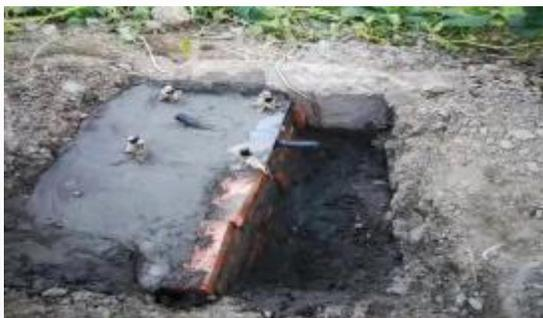
1. 挖坑埋置太阳能地笼，搅拌混凝土做基座，留出地笼头。
